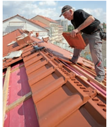
Die neuen Ziegeldächer wurden im System mit KoraTech Unterdeckbahnen ausgestattet
