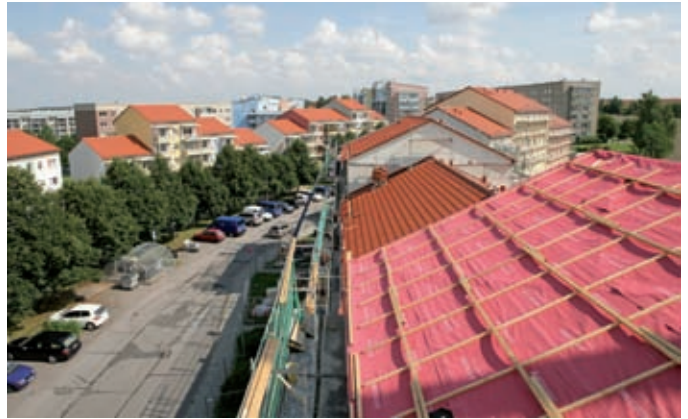
Die neuen Ziegeldächer wurden im System mit KoraTech Unterdeckbahnen ausgestattet
