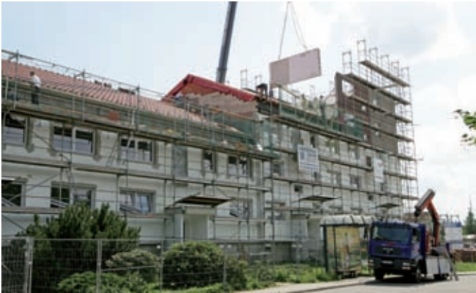
Rückbau des Plattenbaus: vorsichtige Demontage Stück für Stück
